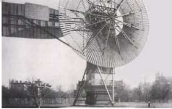
1888 : turbine de Charles Brush Puissance : 12 kW – Cleveland (US)
